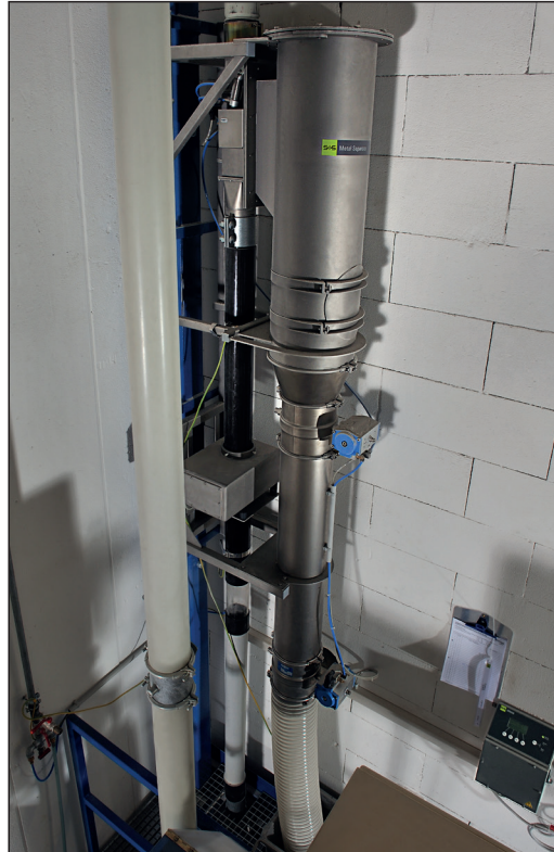
Einbaubeispiel: Metall-Separatoren der Serie GF 4000 eingebaut in vertikale Druck-Förderleitungen (alte Ausführung)
